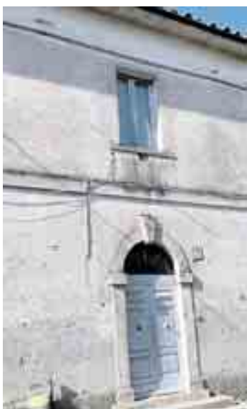
L'ex scuola elementare della frazione di Morrano di Orvieto
